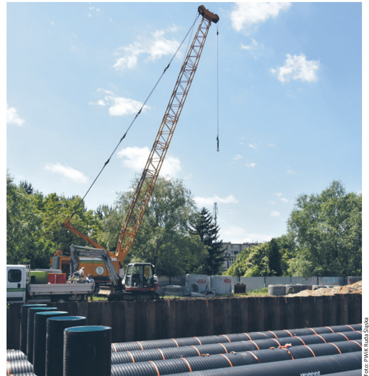
Obecnie m.in. trwa budowa przepompowni ścieków przy ul. Morskiej w Halembie.
