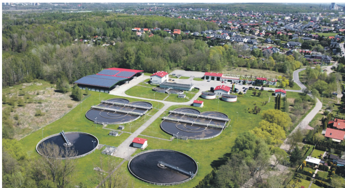
Najwięcej paneli, bo 740 działa na terenie oczyszczalni ścieków „Halemba-Centrum”.
