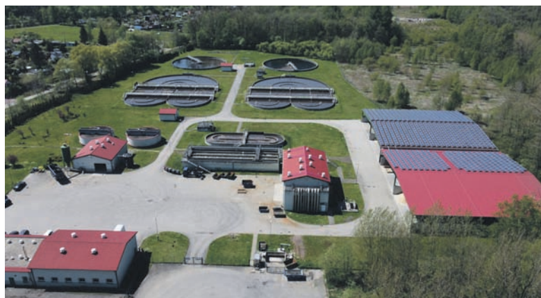
Prąd wyprodukowany przez instalację wykorzystany zostanie w całości przez urządzenia oczyszczalni.
