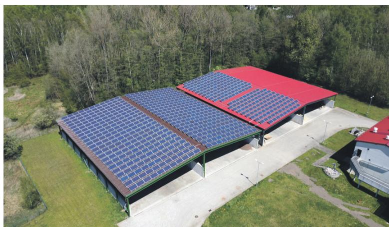
Panele zamontowano na zadaszeniu poletka osadowego.
