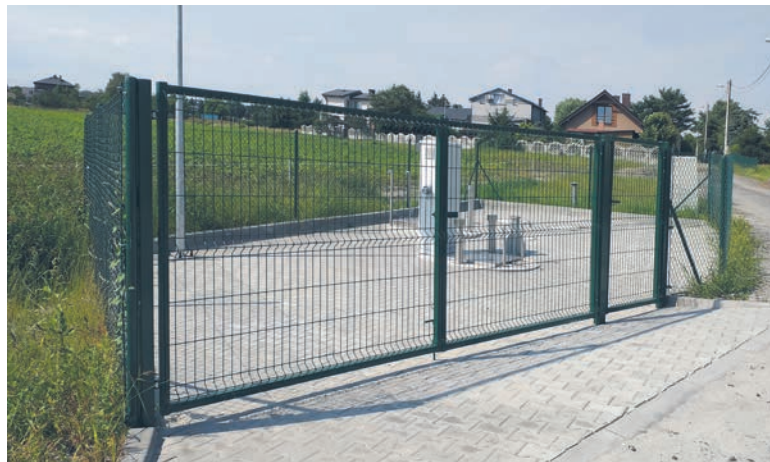
Przy okazji inwestycji przy ul. Studziennej wykonana została nowa przepompownia ścieków.
