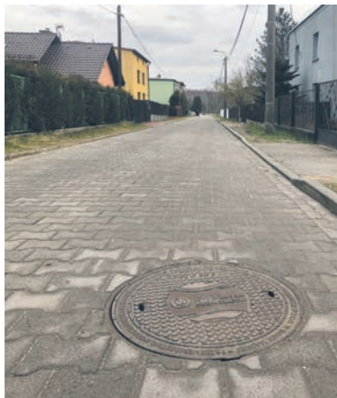
W ramach projektu wybudowano kanalizację m.in. przy ul. Kochanowskiego.
